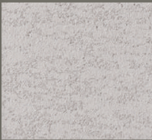
[バリアル] 吹付け+ 角コテ押え
