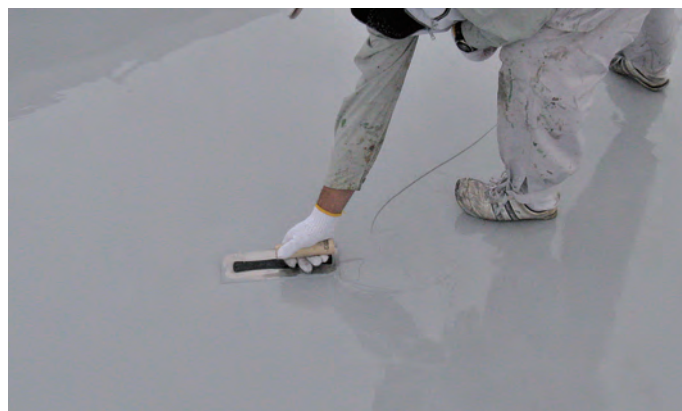
防水材の施工(2層目)
