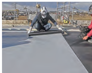
▲ブルーフロンNT-FタックシートSの張り付け
