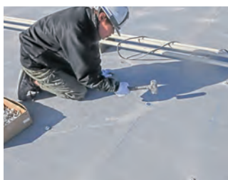
▲メカニカルアンカーの打ち込み
