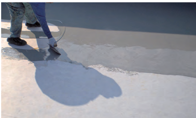
防水材の施工(1層目)
