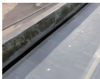
▲末端テープの張り付け
