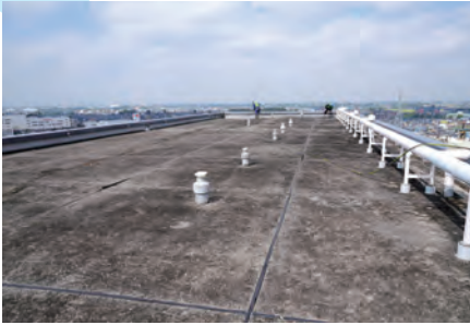
屋上防水改修施工前
