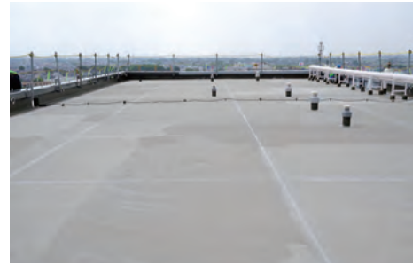
下地処理完了
