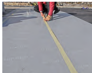
▲ジョイントテープの施工
